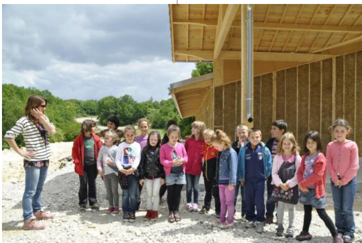
Les élèves de CP et CE1 devant le chantier de leur nouvelle école
